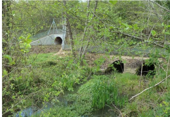
Réalisation d'un écoduc proche d'un ouvrage hydraulique (Département de Charente-Maritime - 17) (@VINCI Autoroutes).
