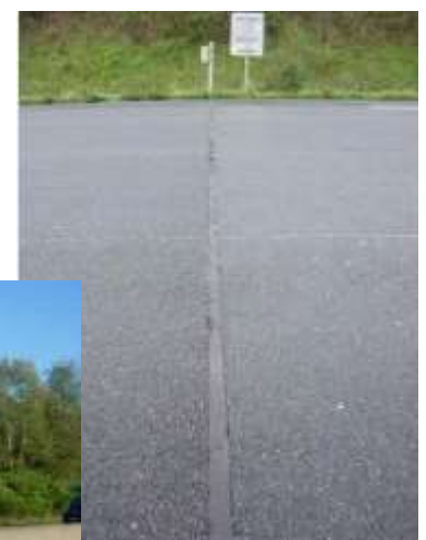
Passage du raccordement électrique sous les voies de circulation
