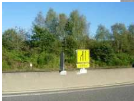
Installation du panneau sur le terre-plein central
