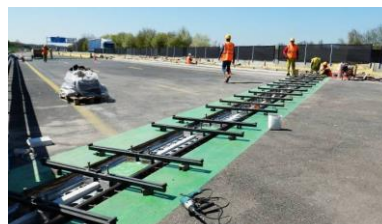
Remplacement des joints de chaussées
