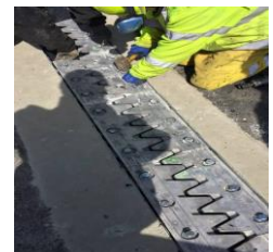
Remplacement des joints de chaussées
