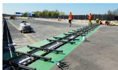
Remplacement des joints de chaussées
