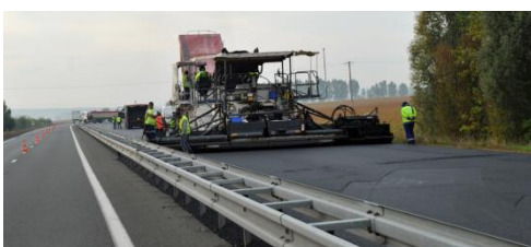
Rénovation de la couche de roulement de la chaussée
