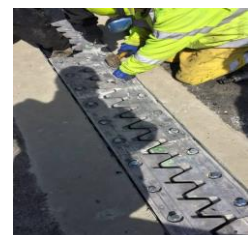
Remplacement des joints de chaussées
