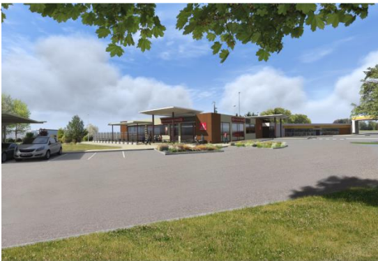
Aire de services de Blois-Villerbon, A10, sens Paris vers Tours
